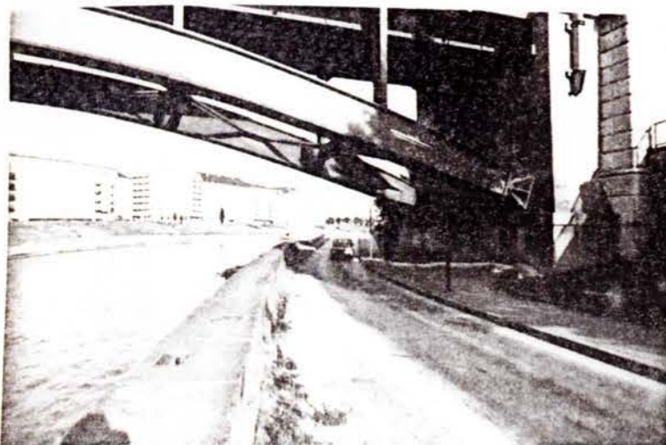
Unterführung Franzens- u. S-Bahn Brücke
