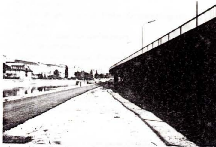
ehemalige Kragkonstruktion bei Station Schottenring
