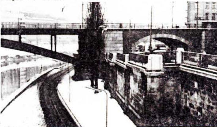
Engstelle Franzens-Brücke, S-Bahn-Brücke
